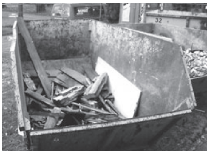
Praktizierte Trennung von Altholz und anorganischen Materialien an der Baustelle
